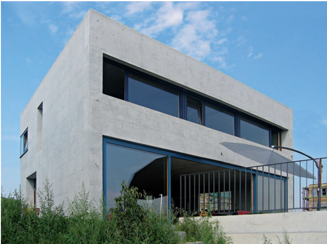
Die größte Fassadenfläche ist nach Süden ausgerichtet, um ein Maximum an Sonnenenergie aufnehmen zu können. Die Wärme wird zeitverzögert ins Innere abgegeben, die Räume sind so vor sommerlicher Überhitzung geschützt.
