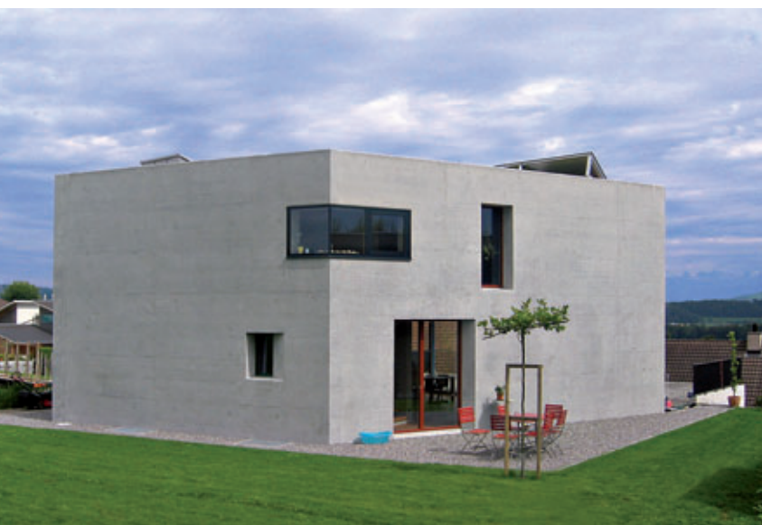
Der monolithische Gebäudekubus aus Isolationsbeton nutzt die Sonneneinstrahlung maximal aus und sorgt mit seiner hohen Wärmespeicherkapazität für ein behagliches Raumklima bei niedrigen Energiekosten.
